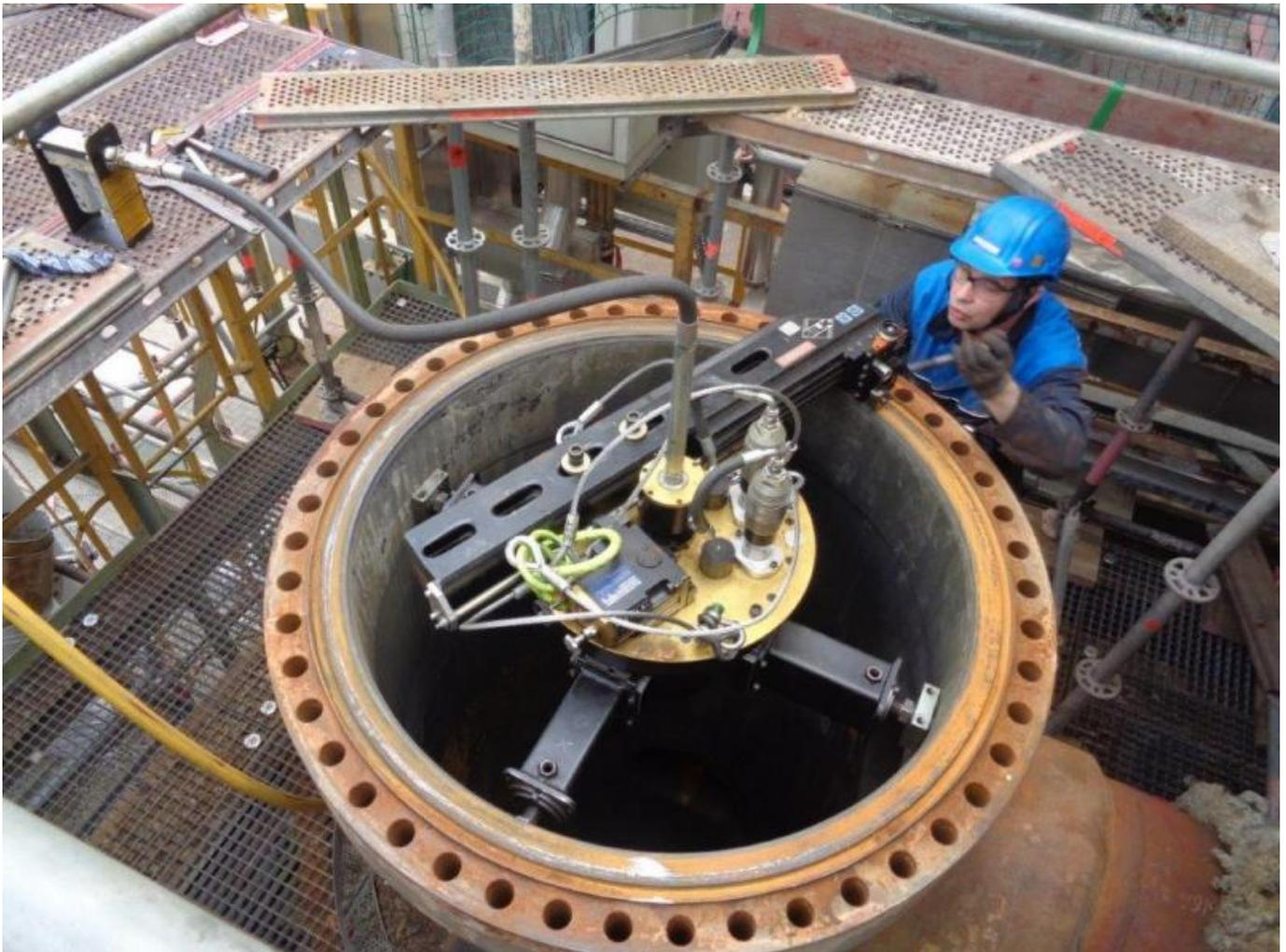
Die notwendigen Prüfungen der einzelnen Rohre mittels des Wirbelstromverfahrens wurden vom TÜV durchgeführt, für den sicheren Rohrverschluss hat sich TOTAL für die patentierten und TÜV zertifizierten Pop-A-Plug Rohrstopfen der EST Group entschieden, die in Deutschland exklusiv von Bardenhagen vertrieben werden.
