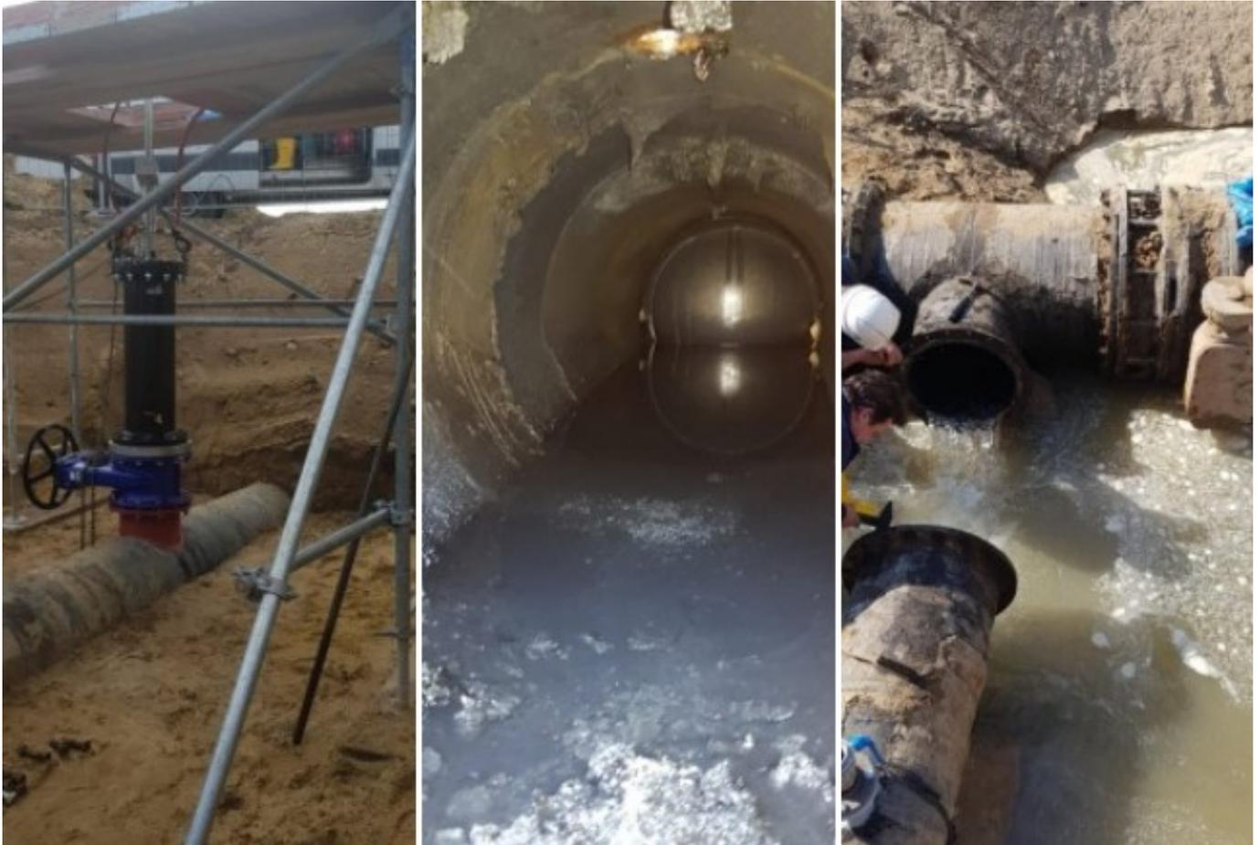
Nach dem Durchbohren der Leitung und dem Zurückziehen des Bohrers mit der gehaltenen Ronde wurde die Anbohrung abgeschiebert und dann die zusammengefaltete Blase eingeführt und mit Druckluft aufgeblasen. Die Blase hielt das Wasser in einem rund 7 km langen Leitungsabschnitt 10 Stunden lang zurück, rund 1,5 km der Leitung wurden entleert, um die defekte Klappe austauschen zu können. Mit dem Anbohren und dem Setzen der Blase waren 2 Bardenhagen- Techniker 2 Tage beschäftigt.
