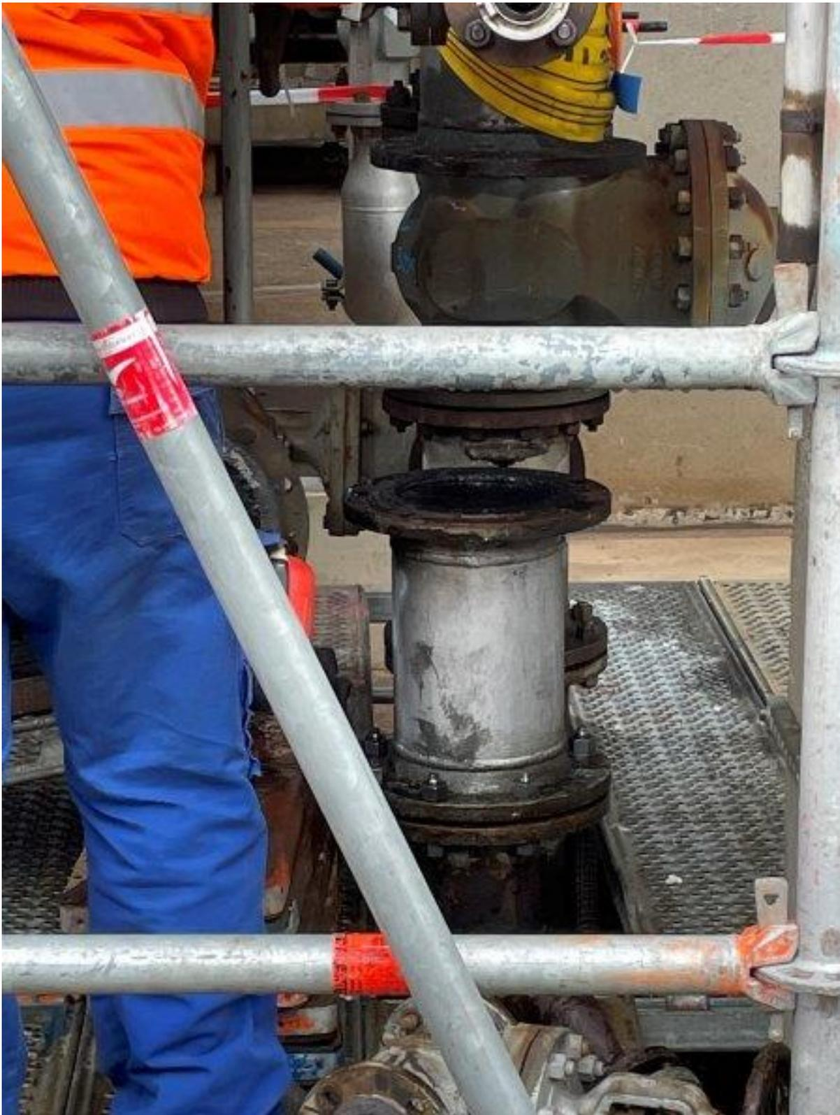
Bei der Raffinerie PCK in Schwedt trat vor kurzem ein Problem auf, das schnell gelöst werden musste. Nachdem die Ursache bei einer Wärmetauschergruppe lokalisiert wurde, die Teil der FCC Anlage war, also zum Herzen der Raffinerie gehört, musste diese im laufenden Betrieb vom Kühlwassernetz genommen werden, um Schieber und Passstücke zu tauschen.
