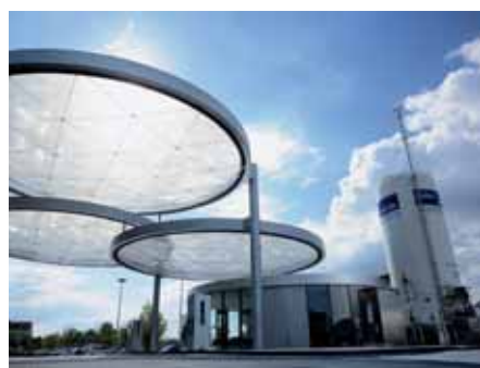
Linde Wasserstoff-Zentrum, Unterschleißheim, Deutschland Linde Hydrogen Center, Unterschleißheim, Germany
