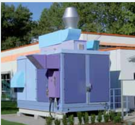
Brennstoffzellen-Heizkraftwerk Fuel cell power station
