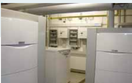
Brennstoffzelle Baunatal Fuel cell Baunatal
