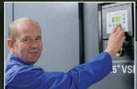
Wilfried Rasch, Fachkraft für Abwassertechnik, hat die Sickerwasserbehandlungsanlage mit aufgebaut und kontrolliert täglich die Luftqualität in den Becken sowie die Leistung der Kompressoren.
