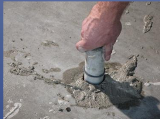
Verschließen der Bohrung
