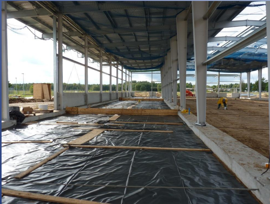
Vorbereitung zur Betonierung für den Schaumbeton als Bodenaustausch
