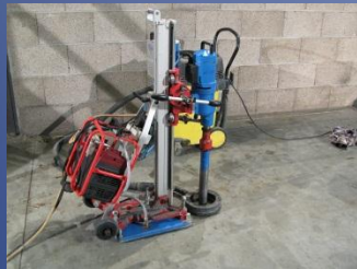
Bohrung für Injektion
