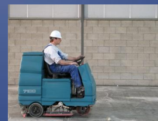
Reinigung der Bodenplatte
