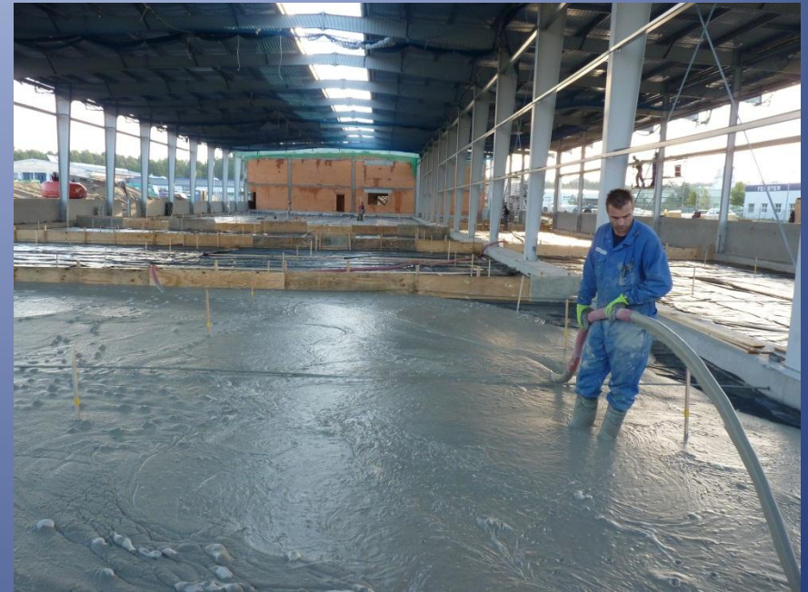
Betonierung als Unterbeton und Bodenaustauschmaterial
