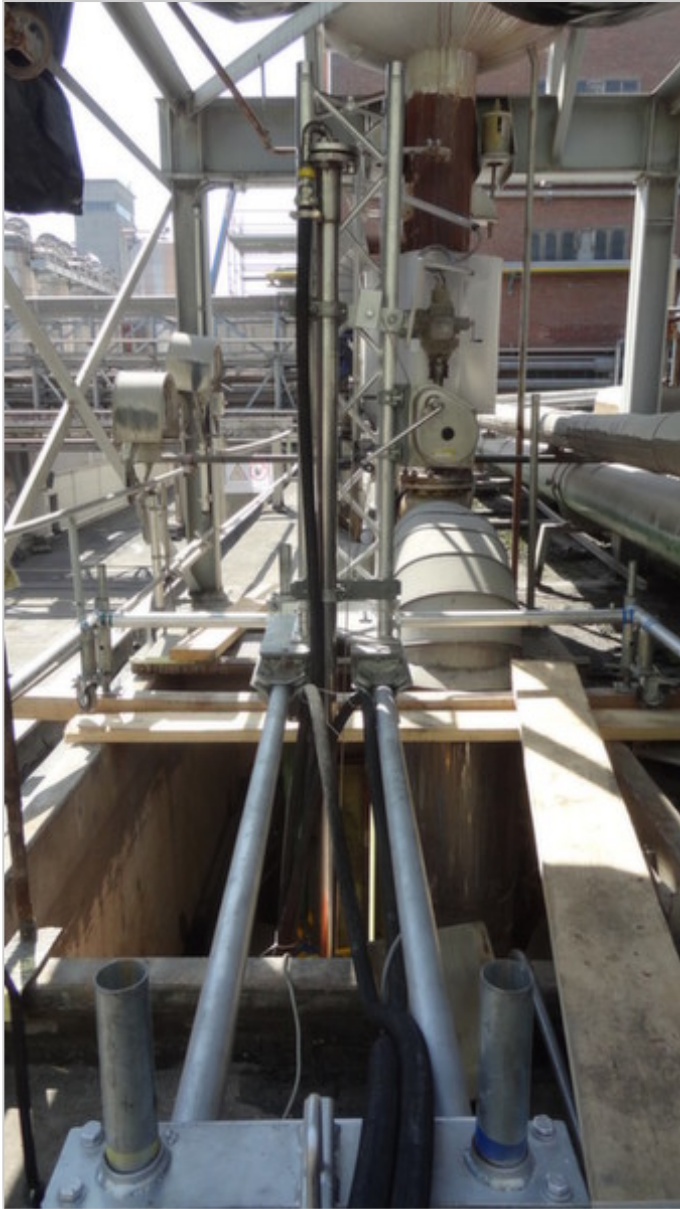
Entfernung verkokter Maisstärke aus Edelstahlverdampfer (Bild: AC Rädler)
