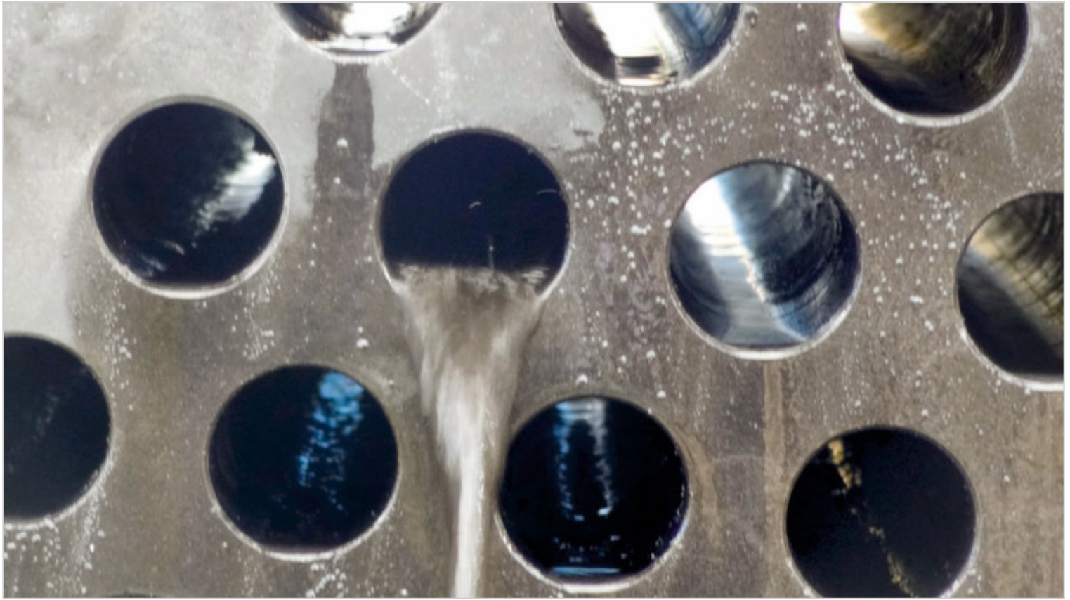
Graphitröhrenwärmeaustauscher – Mit 40 bar HD und Bürsten vorgereinigt – RTC entfernt sämtliche Restbeläge und Regenerierte verblockte Tauscherröhre – horizontale Reinigung (Bild: AC Rädler)
