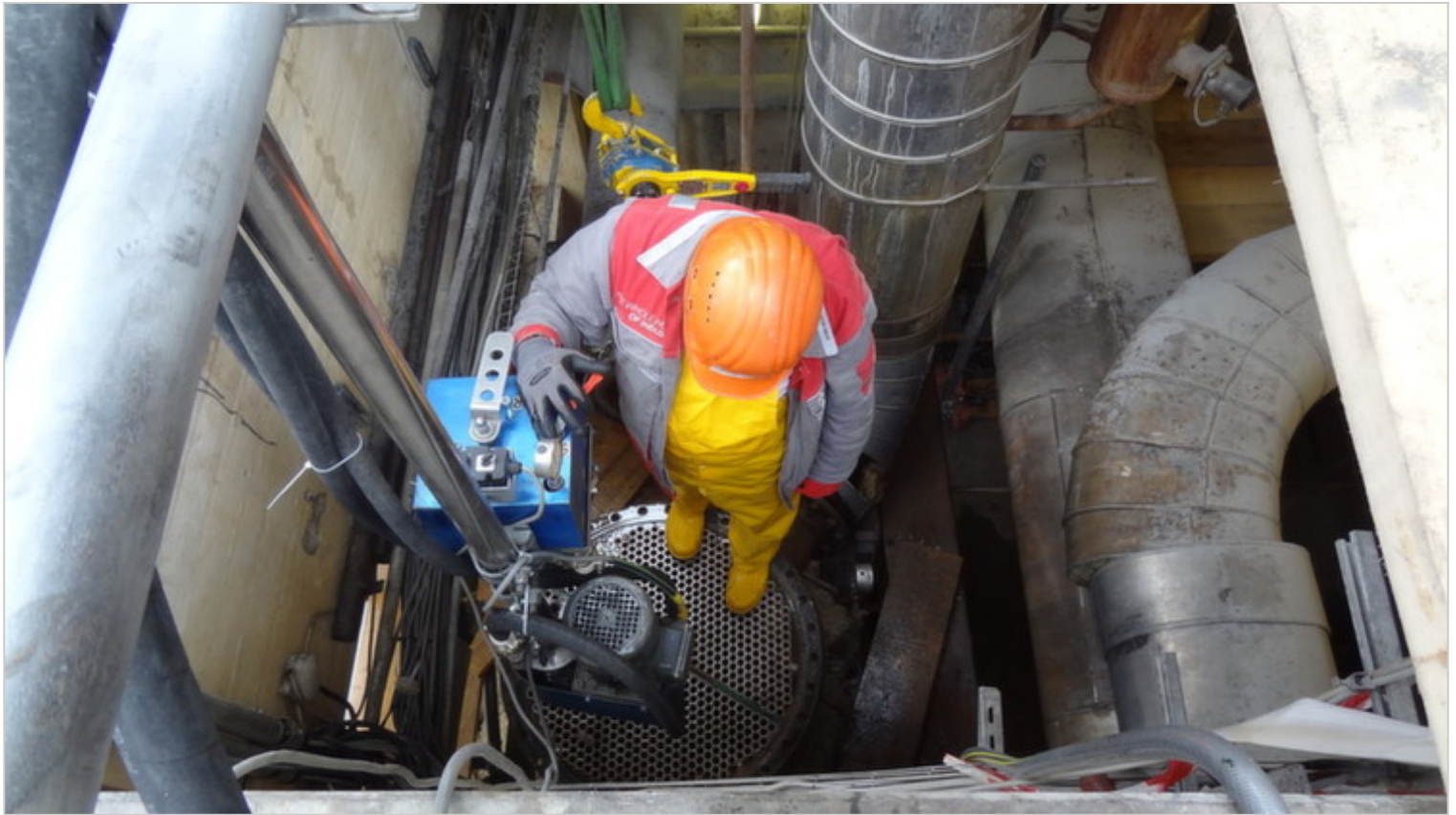
Entfernung von Kalksteinbelägen eines Notkondensators, teilweise 3 m komplett verlegt – vollständige Tauscherregeneration, Rohrblankes Reinigungsergebnis – vertikale Reinigung (Bild: AC Rädler)
