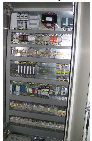
Neue Umrichteranlage bei der Fa. Soer-Norge
