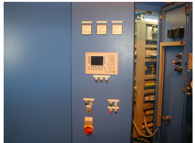
Nachher: Neue Anlagensteuerung bei der Fa. E.G.O.
