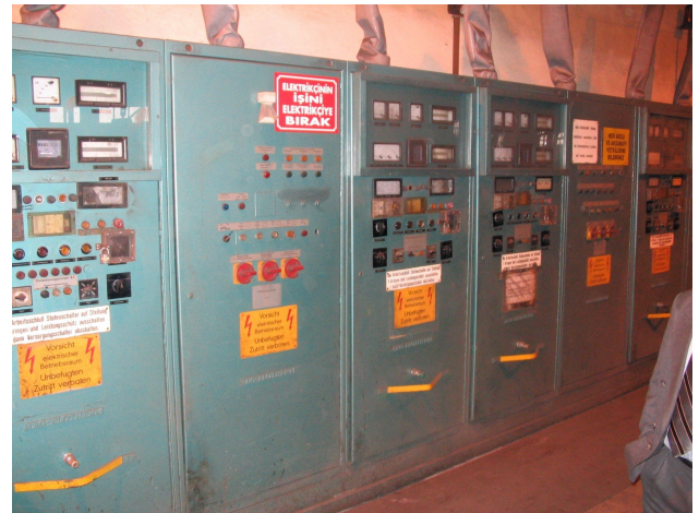
Vorher: Vorhandene Anlagensteuerung bei der Fa. E.G.O.
