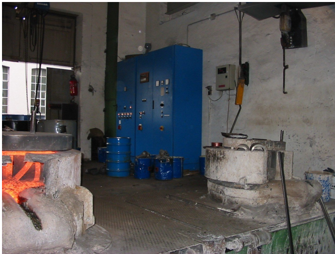
Ofenanlage bei Firma Nippes & Schmidt nach der Modernisierung
