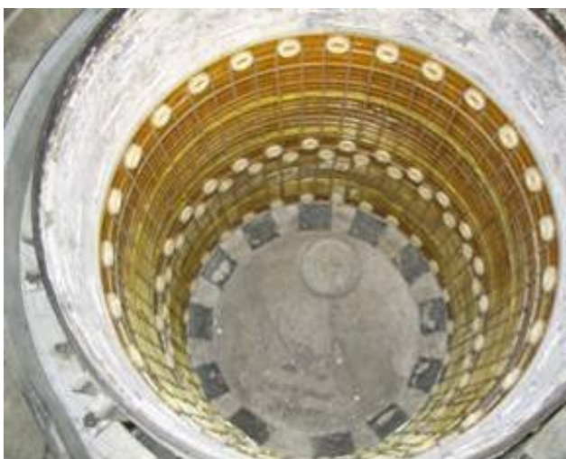
Einbau des OCP-Sensorkabels
