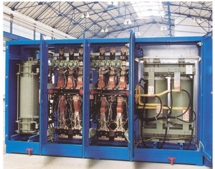
Umrichterschrank bei Bruzaholms Bruk
