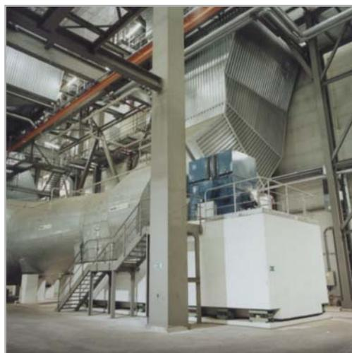
**Lüfter in Klimaanlage mit variabler Drehzahl**
